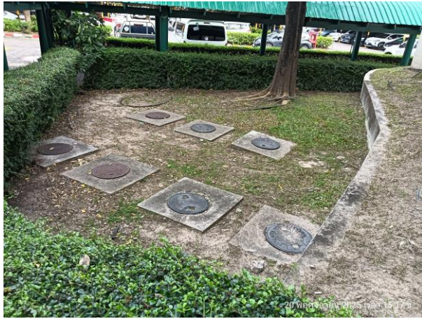
รูปที่ 3-20 ถังกรองใโรอากาศ สำหรับบำบัดน้ำเสีย จากกิจกรรมของพนักงาน
