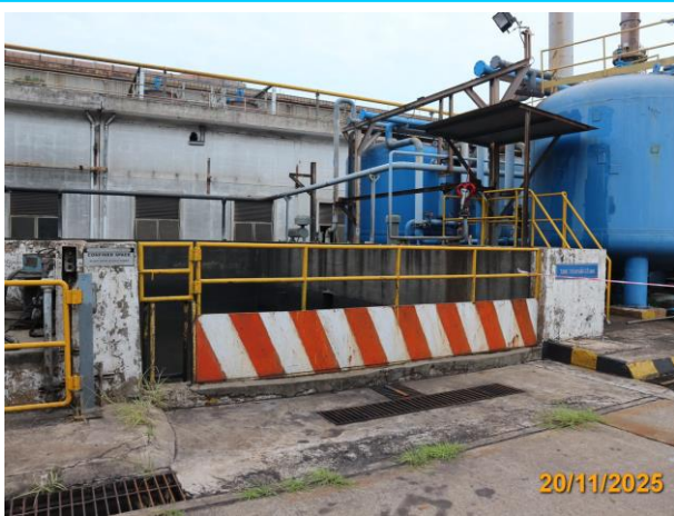
รูปที่ 3-32 บ่อเก็บรวบรวมน้ำจาก Sludge เพื่อส่งไปยัง Irrigation Pond และนำกลับมาหมุนเวียนใช้ใหม่
